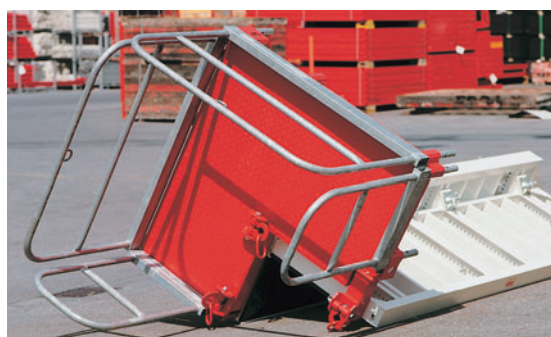
La piattaforma di servizio viene montata sul semipilastro disteso a terra.
