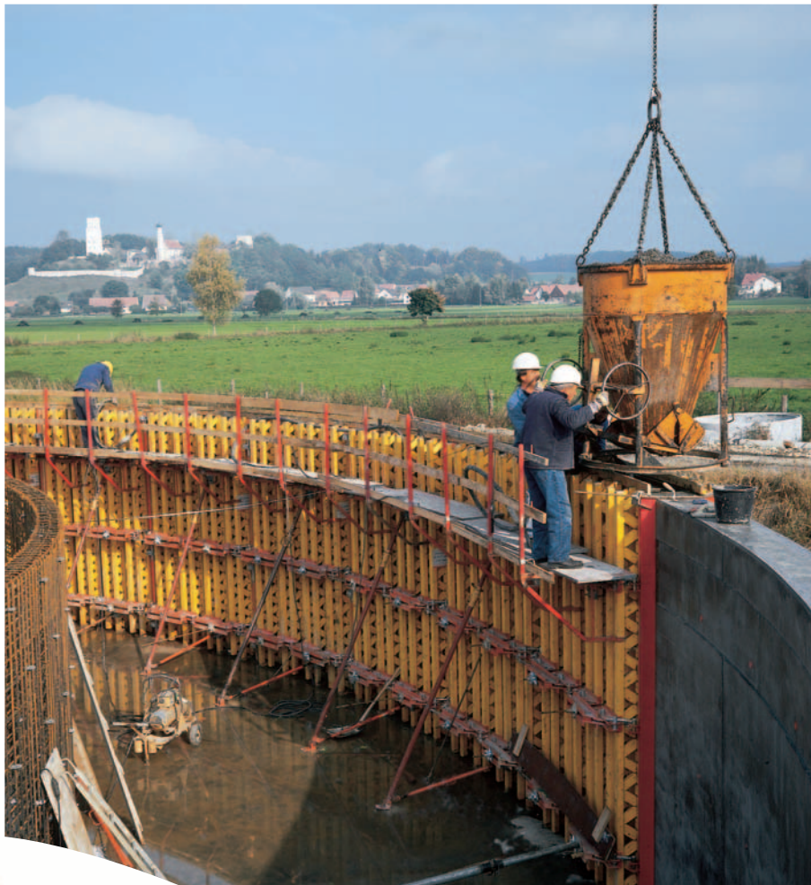
Cassaforma RUNDIFLEX, per differenti raggi di curvatura, con un'altezza di 3,60 m per la costruzione di un impianto di depurazione.
