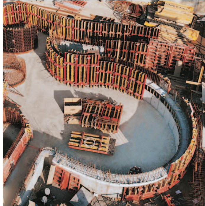
RUNDFLEX utilizzato per la costruzione di una piscina all'aperto. Raggi di curvatura variabili tra 1,50 m e oltre 20,00 m sono stati armati rapidamente e senza difficoltà.
