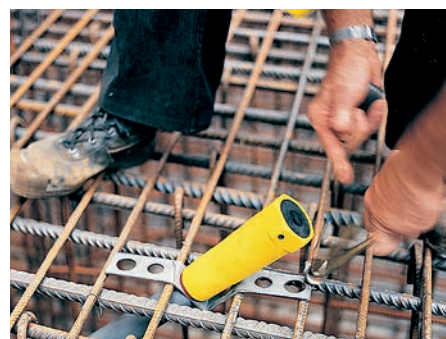
Sistema di ancoraggio fissato ai ferri di armatura semplicemente con filo metallico e pinza.
