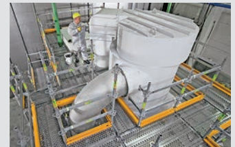
Ponteggi per l'industriale
