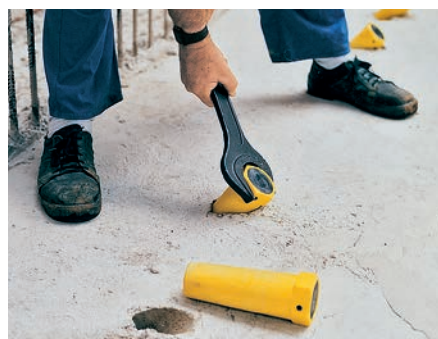
Rimozione del cono di predisposizione con chiave SW 70.
