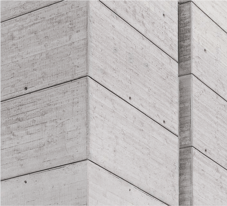
Esemplare finitura superficiale del calcestruzzo a vista con impronta orizzontale delle tavole in legno.
