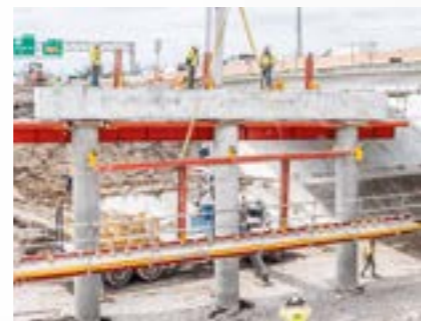
L'innovativo metodo di disarmo split-soffit accelera enormemente il tempo di ciclo e richiede meno dotazioni di casseforme.
