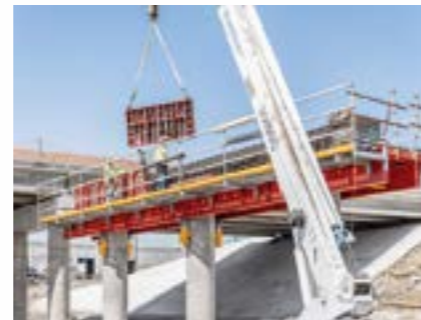
VSS consente l'uso indipendente delle casseforme laterali. Ciò rende più agevole le operazioni di armo e permette il disarmo il giorno successivo.
