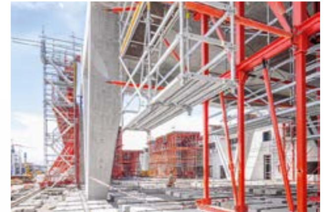
L'impalcatura modulare PERI UP in combinazione con VARIOKIT realizza accessi sicuri alle varie zone di lavoro.
