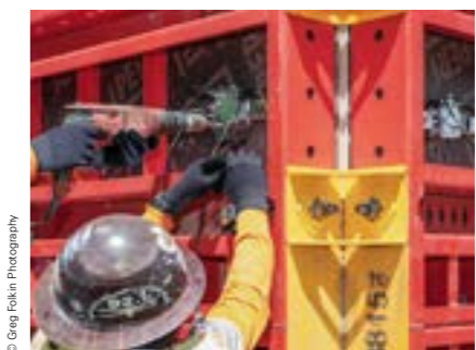
Il sensore di pressione InSite Construction è un ulteriore importante elemento per accelerare il processo di getto del calcestruzzo.
