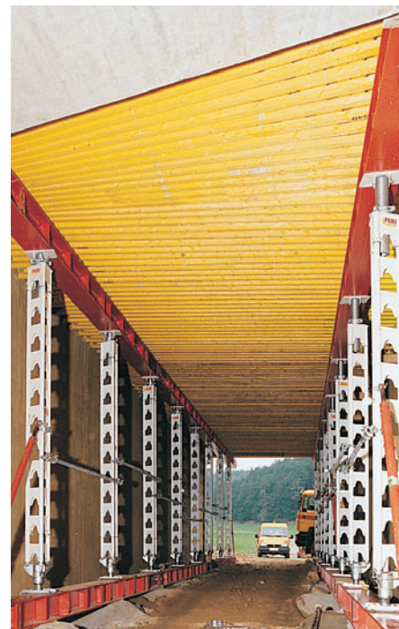
Impalcato stradale di 60 m di lunghezza sostenuto da HD 200.
