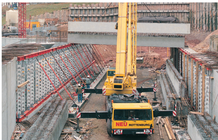
Stilate di puntoni PERI HD 200 per supportare travi prefabbricate in c.a.
