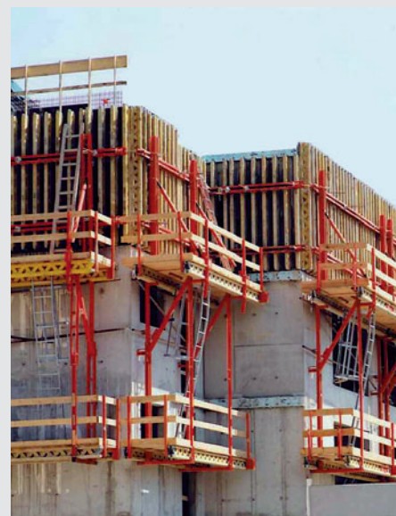
Sicurezza Scale PERI per l'accesso in sicurezza alla passerelle inferiori.
