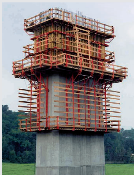
Pila di un ponte Calcestruzzo faccia a vista con CB 240 e VARIO GT 24.
