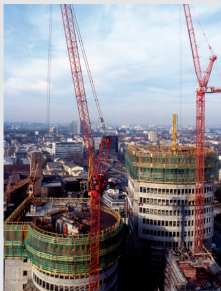
Edificio per uffici CB 240 con TRIO e VARIO GT 24.
