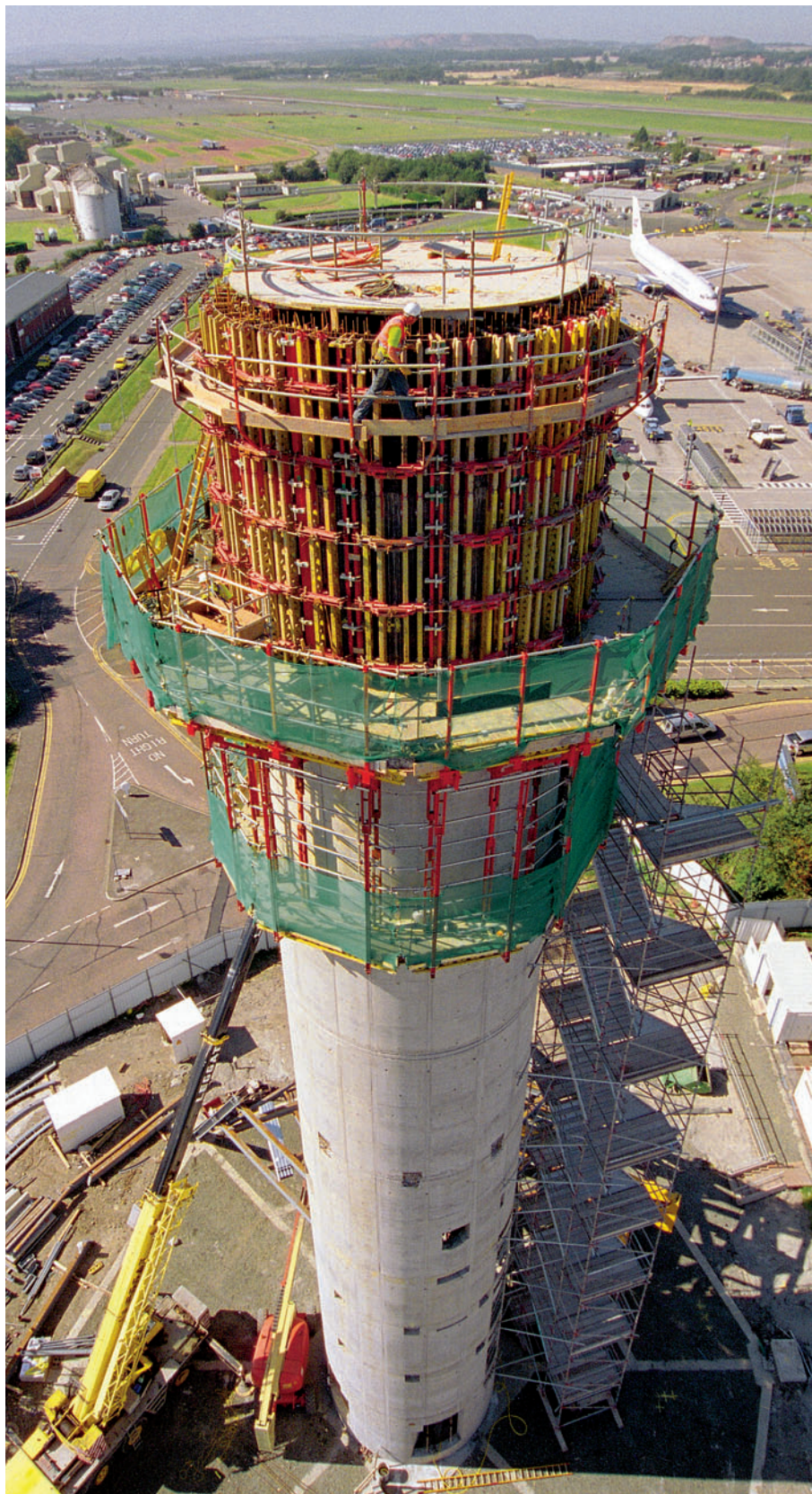
Torre di controllo aeroporto 46 m d'altezza, ø esterno 6,85 m. Realizzata con PERI RUNDFLEX e mensole CB 240.
