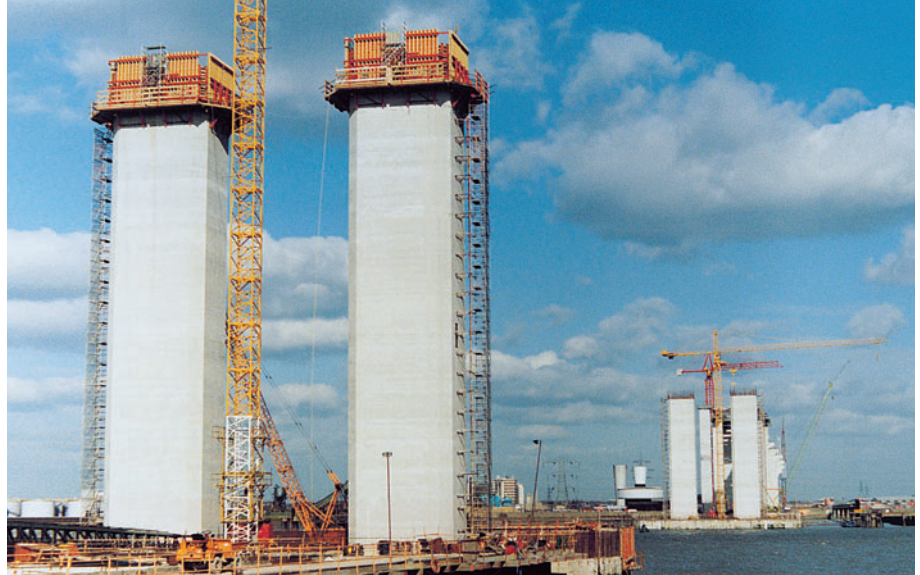
CB 240 abbinata alla cassaforma VARIO GT 24 per la realizzazione delle pile di un ponte.
