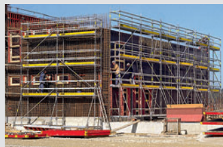
Impalcature di servizio
