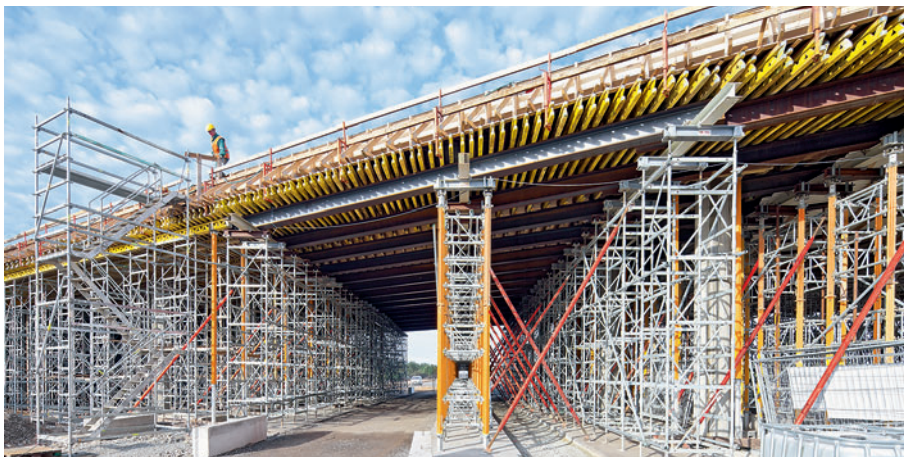
Le travi reticolari GT 24 trasferiscono i carichi del getto in calcestruzzo alla struttura di sostegno studiata appositamente per questo progetto.
