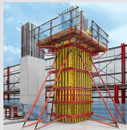
Pilastri di grandi dimensioni armati velocemente ed in sicurezza grazie alla cassaforma per pilastri VARIO GT 24.
