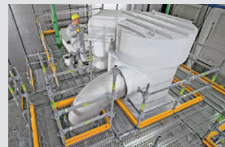
Ponteggi per l'industriale
