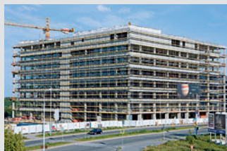
Ponteggi di facciata
