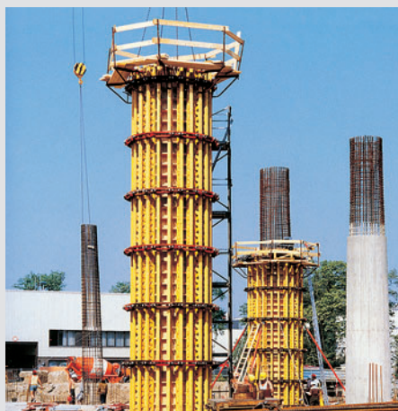
PERI GRV e travi GT 24 impiegati per realizzare una cassaforma per pilastri tronco-conici.
