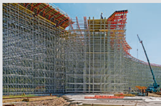
Impalcature di sostegno
