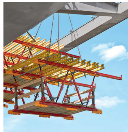
In questo ponte a struttura mista acciaio-calcestruzzo, le travi GT 24 trasferiscono i carichi ad unità di sostegno composte da correnti in acciaio SRU e puntoni ad elevata portata SLS. L'elevata capacità di carico consente di coprire grandi luci con deformazioni minime.
