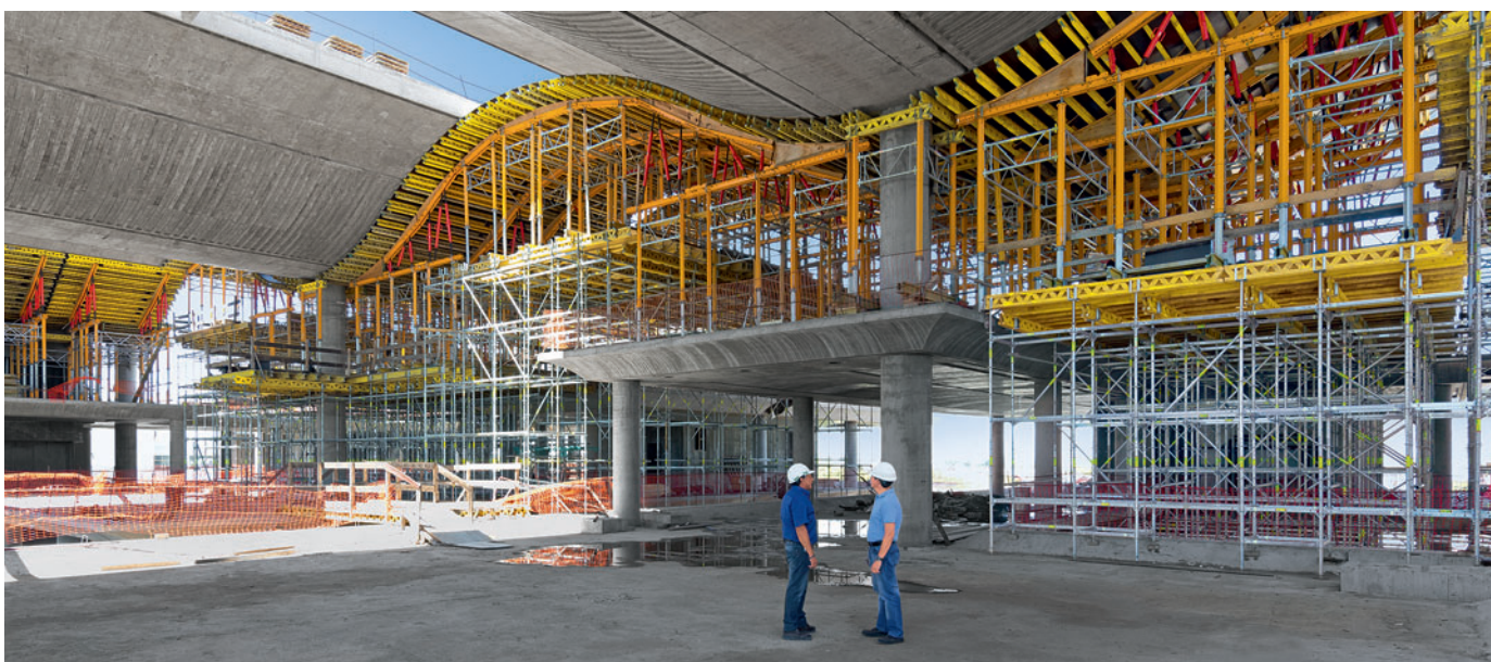
Grazie all'impiego di spessori in legno sagomati e alla struttura di supporto realizzata con il sistema VARIOKIT, questi tavoli per solai sono stati adattati perfettamente alla forma ondulata del tetto.
