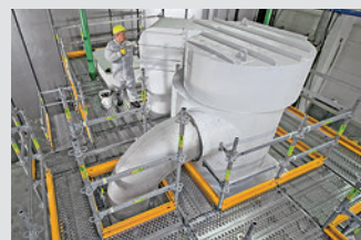
Ponteggi per l'industriale
