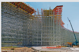
Impalcature di sostegno
