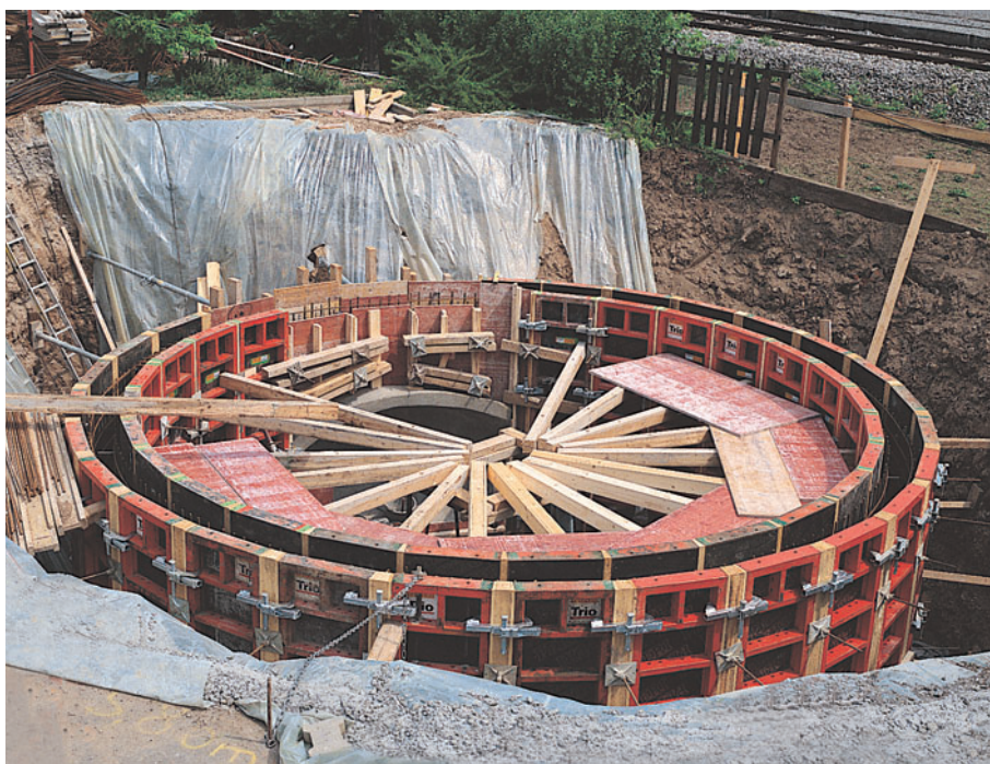
Struttura di un serbatoio, realizzata con elementi TRIO TR 270 x 60
