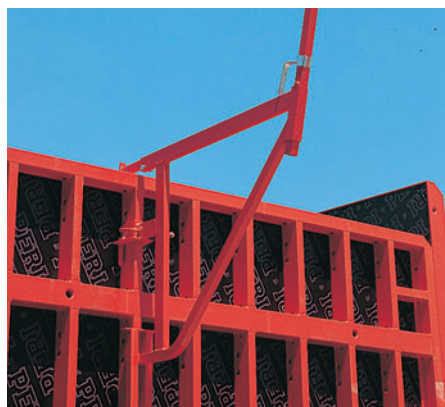
Collegamento al profilato verticale
