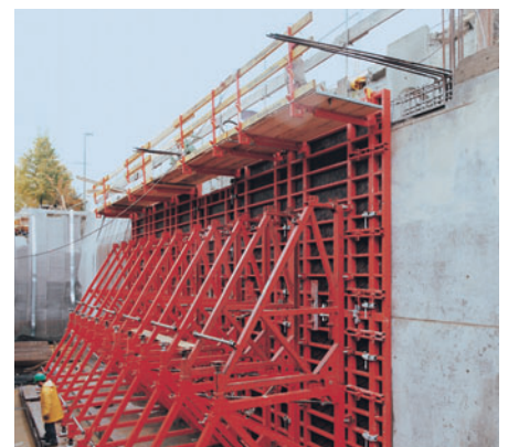
Cassaforma con un solo paramento
