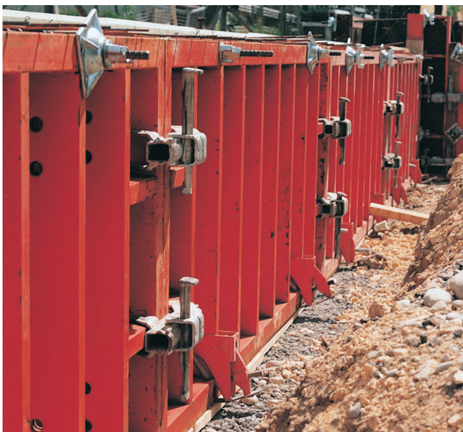
Travi continue di fonda- zione realizzate con il tenditore nastro forato.
