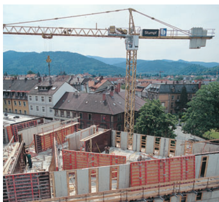
Elementi di lunghezza 9,00 m e altezza 2,70 m rivestite con pannelli di grande dimensione.
