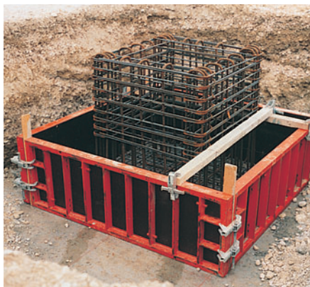
Utilizzo orizzontale degli elementi a telaio per le fondazioni.
