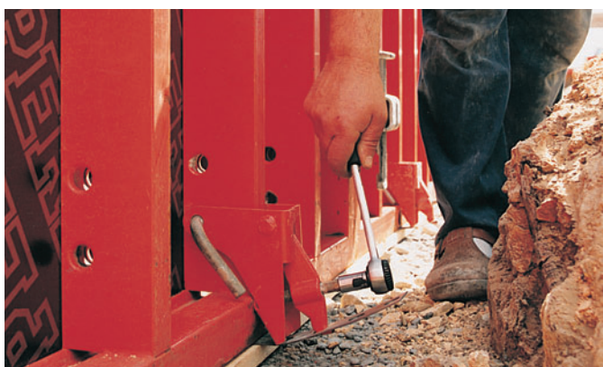
Travi continue di fonda- zione realizzate con il tenditore nastro forato.
