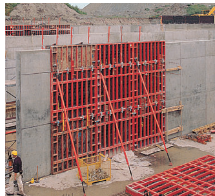
Elementi TRIO orizzontali e sovrapposti, h = 6,00 m.
