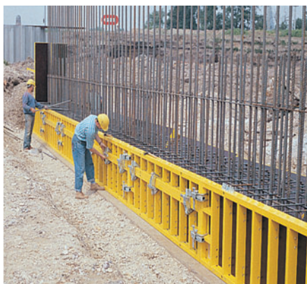
TRIO-L per la cassaforma delle fondazioni
