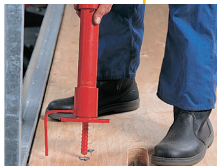
Il montante parapetto FBP per il fissaggio delle tavole parapetto è avvitato nell'attacco multiuso (DW 15).
