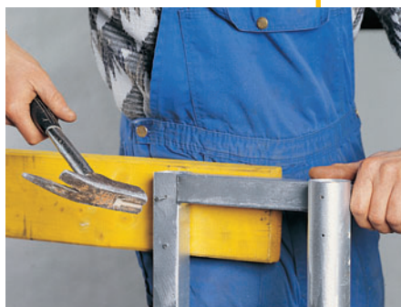
I fori nel telaio del parapetto consentono di inchiodare facilmente le tavole parapetto.
