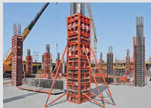
Casseforme per pilastri
