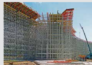
Impalcature di sostegno
