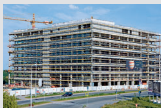
Ponteggi di facciata
