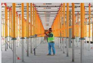
Casseforme per solai
