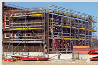
Impalcature di servizio
