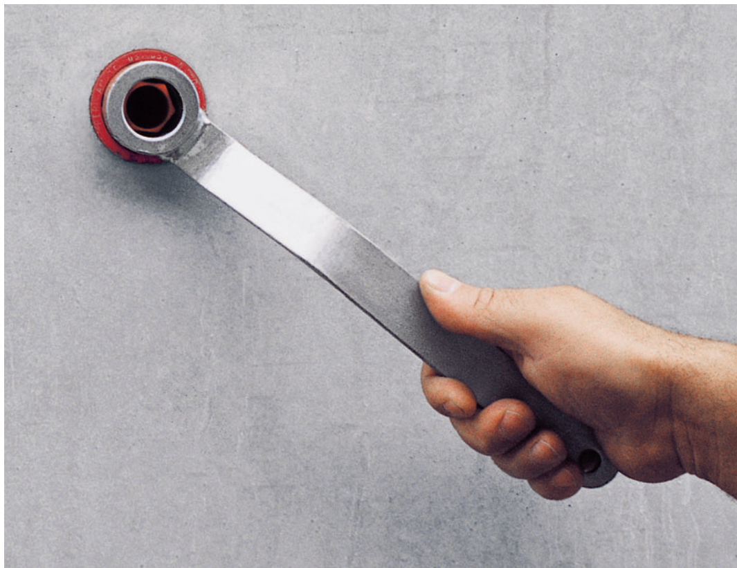
Rimozione del cono DK con la chiave UNI.
