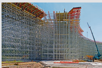
Impalcature di sostegno
