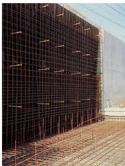
Tunnel di Häggsviksleden, Svezia.
