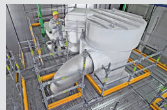
Ponteggi per l'industriale
