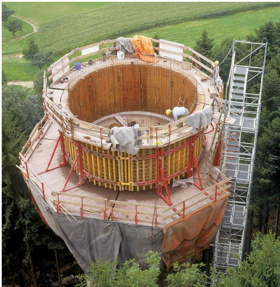
Cassaforma a forma di imbuto per un serbatoio di raccolta dell'acqua piovana di un depuratore.
