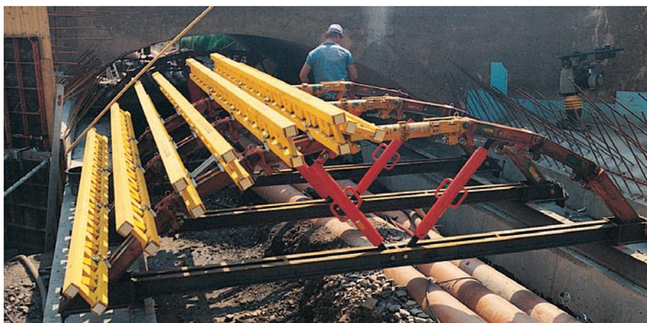
Cassaforma a volta lunga 13,50 m e alta 8,40 m. Correnti con snodo GRV abbinati alle travi GT 24 sostenuti da puntelli di stabilizzazione RS 1000.
