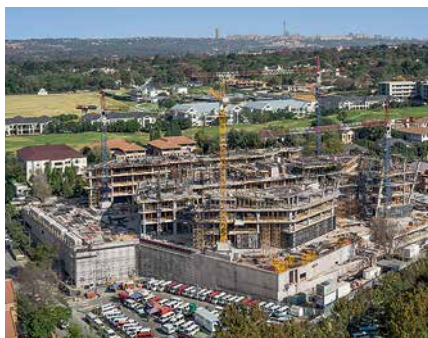
200.000 m 2 di solai costruiti grazie a PERI
