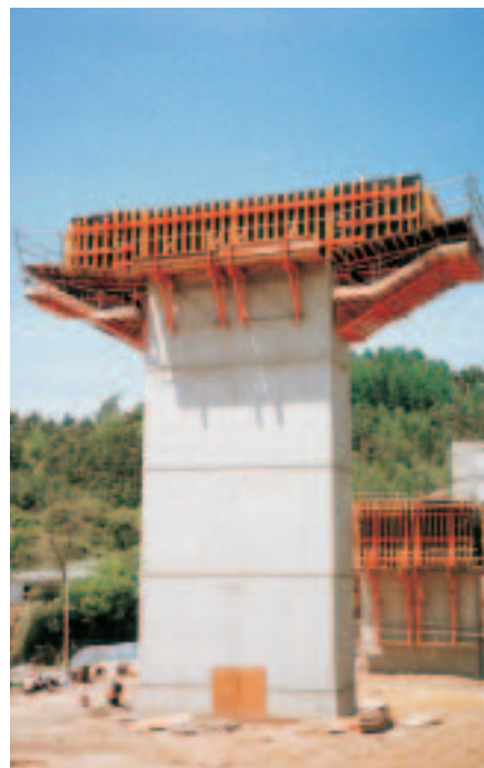
Contrafforte PERI SB-2 che realizza la piattaforma di sostegno di un pulvino.
