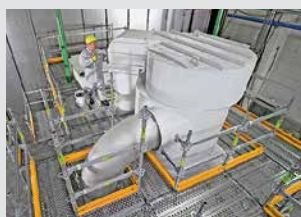
Ponteggi per l'industriale
