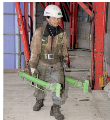
Il meccanismo idraulico, con capacità di sollevamento pari a 5 t, pesa soltanto 25 kg e può essere facilmente spostato a mano.
