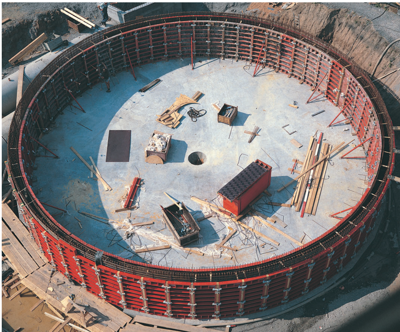
Struttura con un diametro di ca. 18 m, realizzata con elementi TRIO TR 270 x 90
