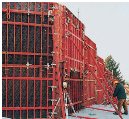
L'accoppiamento di elementi a telaio sfalsati
