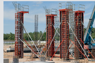
Casseforme per pilastri
