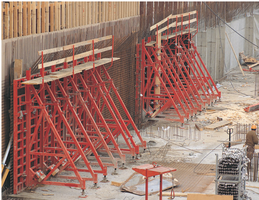
TRIO fino a 3,90 m di altezza con contrafforti SB-B e SB-C.
