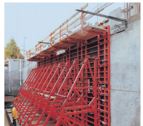
Cassaforma con un solo paramento
