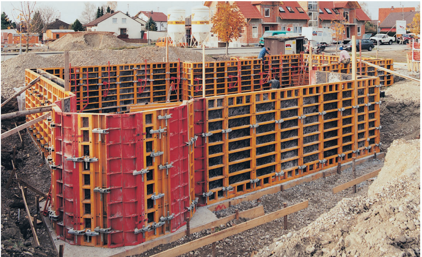
Gli elementi TRIO-L sono disponibili in 4 diverse lunghezze e nelle altezze 270 e 90 cm
