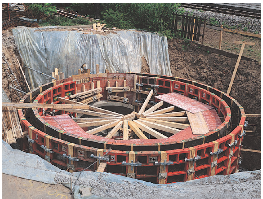
Struttura di un serbatoio, realizzata con elementi TRIO TR 270 x 60
