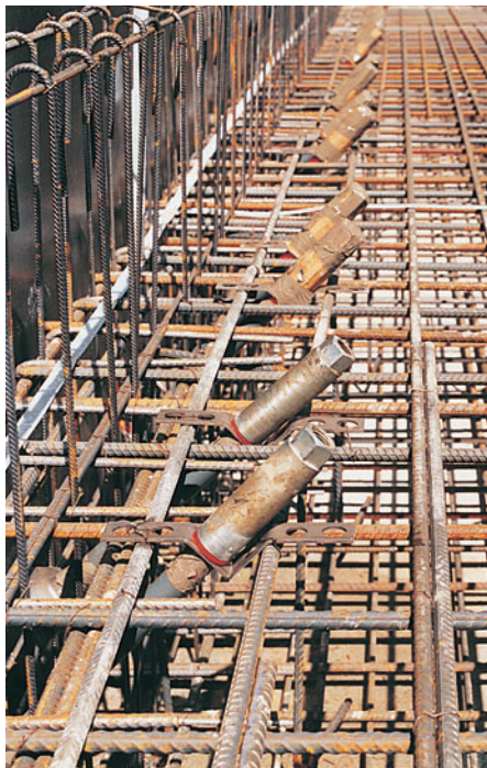
PERI V - il posizionatore dei tiranti è disponibile per DW 15, DW 20 E DW 26. L'ancoraggio con l'inclinazione di 45° dei contrafforti viene posizionato facilmente.
