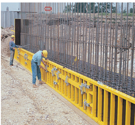
TRIO-L per la cassaforma delle fondazioni
