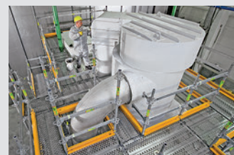
Ponteggi per l'industriale
