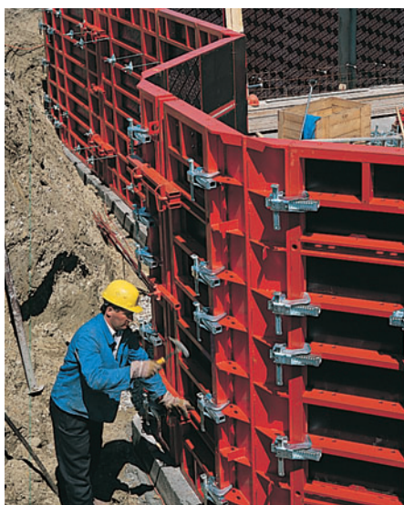
Congiunzione di elementi angolari con cerniera
