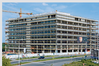
Ponteggi di facciata
