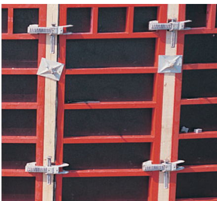
Qui si vede chiaramente: la morsa BFD non è posta sui profilati trasversali
