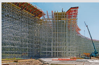
Impalcature di sostegno
