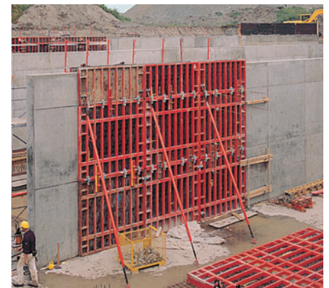
Elementi TRIO orizzontali e sovrapposti, h = 6,00 m.
