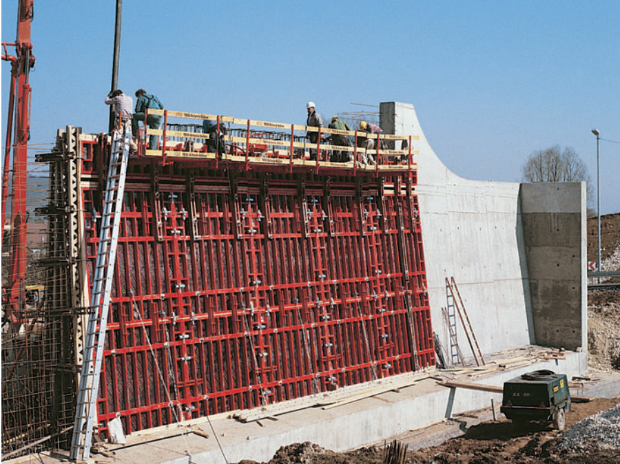
Pareti di sostegno
