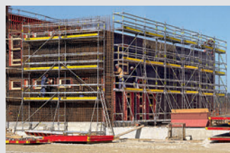
Impalcature di servizio
