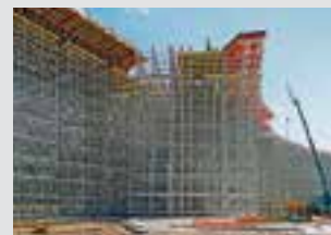
Impalcature di sostegno
