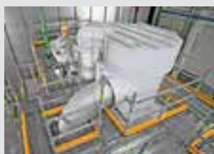
Ponteggi per l'industriale
