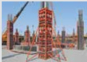
Casseforme per pilastri
