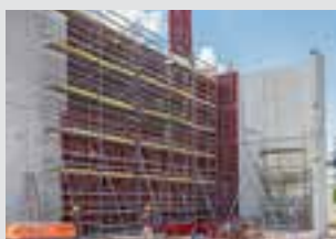
Impalcature di servizio
