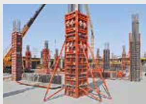
Casseforme per pilastri
