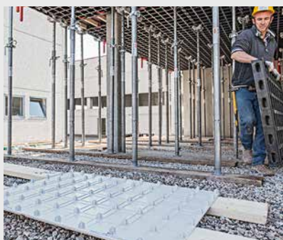
3. Posizionare il nuovo pannello di rivestimento
