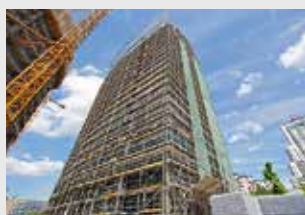
Ponteggi di facciata
