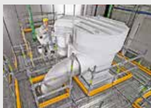
Ponteggi per l'industriale
