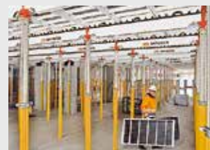
Casseforme per solai
