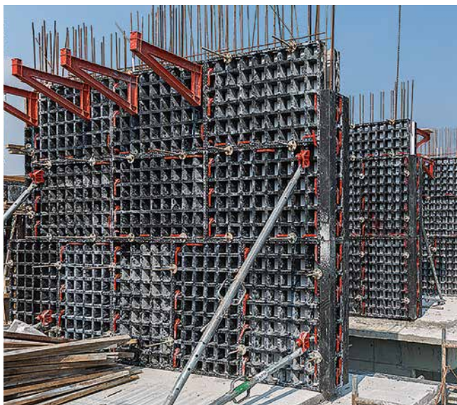
Un successo già dalla prima applicazione: la cassaforma leggera universale per la realizzazione di pareti portanti.
