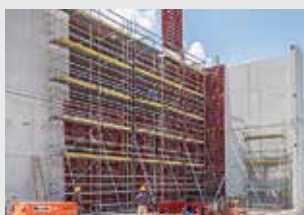
Impalcature di servizio
