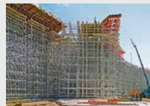
Impalcature di sostegno
