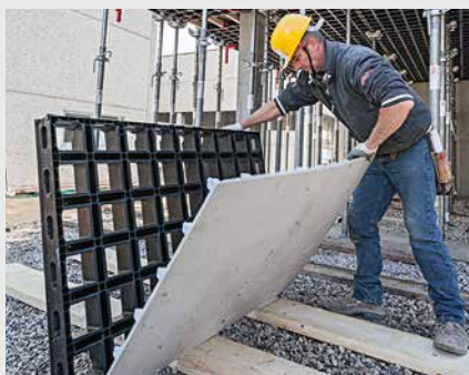
2. Rimuovere il pannello di rivestimento danneggiato
