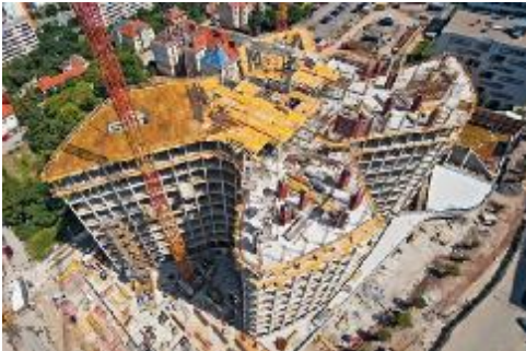
(Fig. 2) Per ognuno dei 17 piani fuori terra con sezione ad arco è stata utilizzata una soluzione completa di casseforme ed impalcature PERI.
