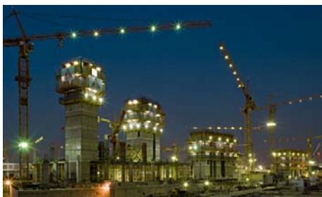
Figura 6: Nell'arco di soli tre anni di lavori nasce un nuovo e gigantesco quartiere nella città di Riad, che costituisce il nuovo centro finanziario del regno d'Arabia Saudita. (Foto: PERI GmbH)
