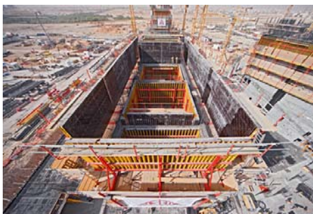
Figura 3: La soluzione RCS per la realizzazione dei nuclei degli edifici. (Foto: PERI GmbH)
