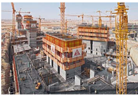
Figura 1: Nel nuovo distretto finanziario di Riad, sono attualmente in costruzione complessivamente cinque nuclei in cemento armato con casseforme a ripresa PERI. (Foto: PERI GmbH)
