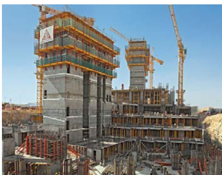
Figura 2: La soluzione costituita da tipologie diverse di casseforme e impalcature PERI è stata adattata in modo ottimale per rispondere alle esigenze di cantiere. (Foto: PERI GmbH)
