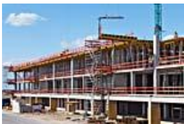
Figura 4: Ogni settimana vengono movimentati circa 8.000 m 2 di tavoli per solai. L'apposito bilancino di sollevamento permette di spostarli rapidamente e in tutta sicurezza. (Fotografia: PERI GmbH)
