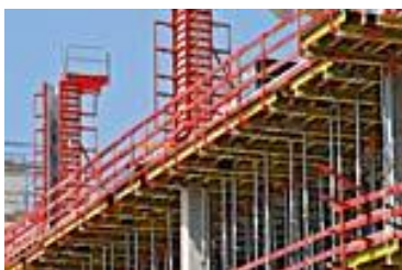
Figura 6: Grazie alla portata elevata della cassaforma per pilastri QUATTRO, che può sostenere una pressione del calcestruzzo fresco di ben 80 kN/m 2 , le operazioni di getto avvengono più rapidamente. (Fotografia: PERI GmbH)
