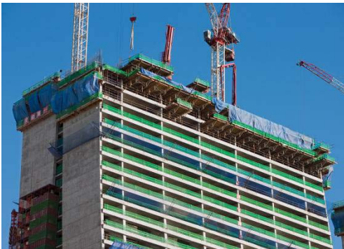
Foto 5 – Con I tavoli PERI SKYTABLE è possibile realizzare due piani alla volta.
