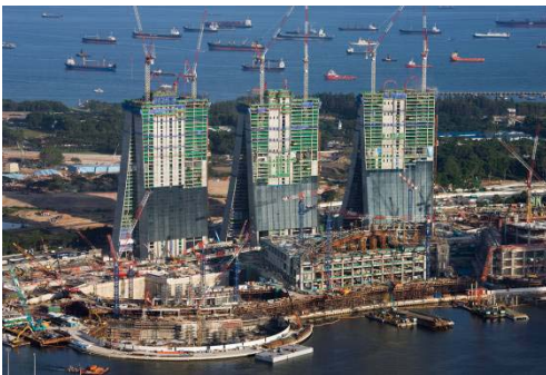
Foto 2 – L'americana Las Vegas Sands Corporation è responsabile della costruzione dell'intero complesso. Grazie alle casseforme e alle strutture provvisionali PERI, ogni piano delle torri viene completato in soli quattro giorni.
