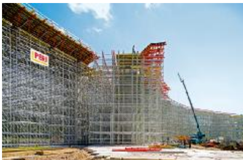
Figura 1: Grazie alla sua modularità e al reticolo metrico, la struttura portante PERI UP si adatta in modo ottimale alla planimetria nonché ai carichi di getto e ai carichi variabili.
