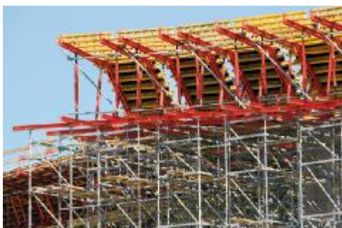
Figura 3: I 'falsi puntoni' del sistema di attrezzature modulari VARIOKIT consentono di realizzare la cassaforma con trave a sbalzo trasferendo in piena sicurezza i carichi alla struttura.
