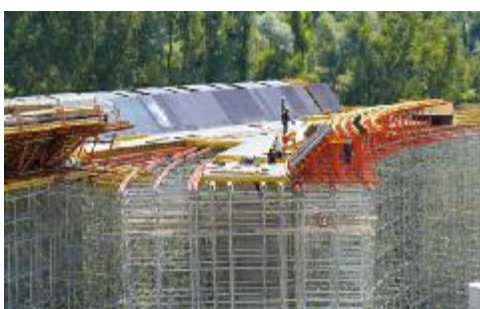
Figura 2: La continua variazione della sezione nella realizzazione della sovrastruttura richiede la massima flessibilità dei sistemi di cassetteria e di impalcatura di supporto utilizzati.
